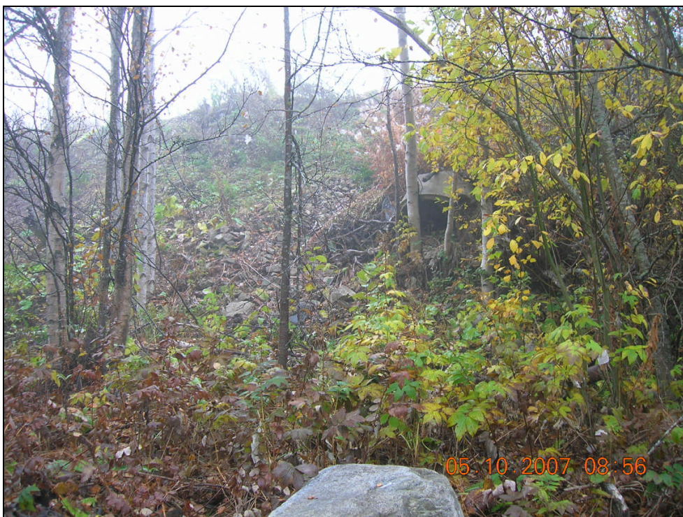
Deponins nordöstra slänt med en uppstickande betongring.
