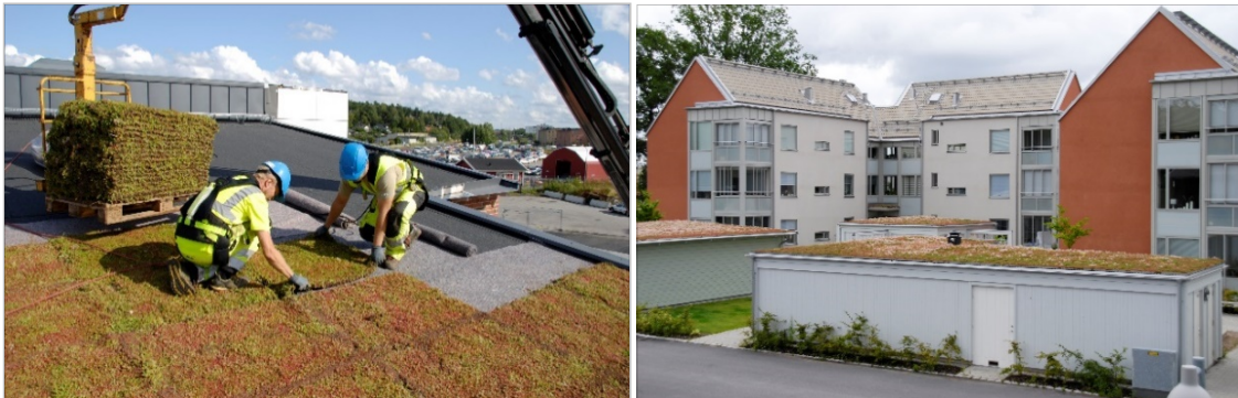
Figur 14. Anläggning av gröna tak till vänster och färdigt tak på miljörum till höger, bilder från vegtech.se.
