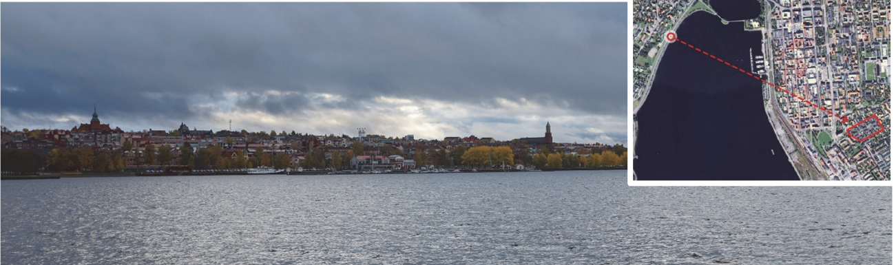
Vy från Frösöns strand, taget något närmare brofästet. strand (Föreslagna byggnader med nockhöjderna +347,30 respektive +344,70). Fotomontage: Alton Öhman Arkitekter.
