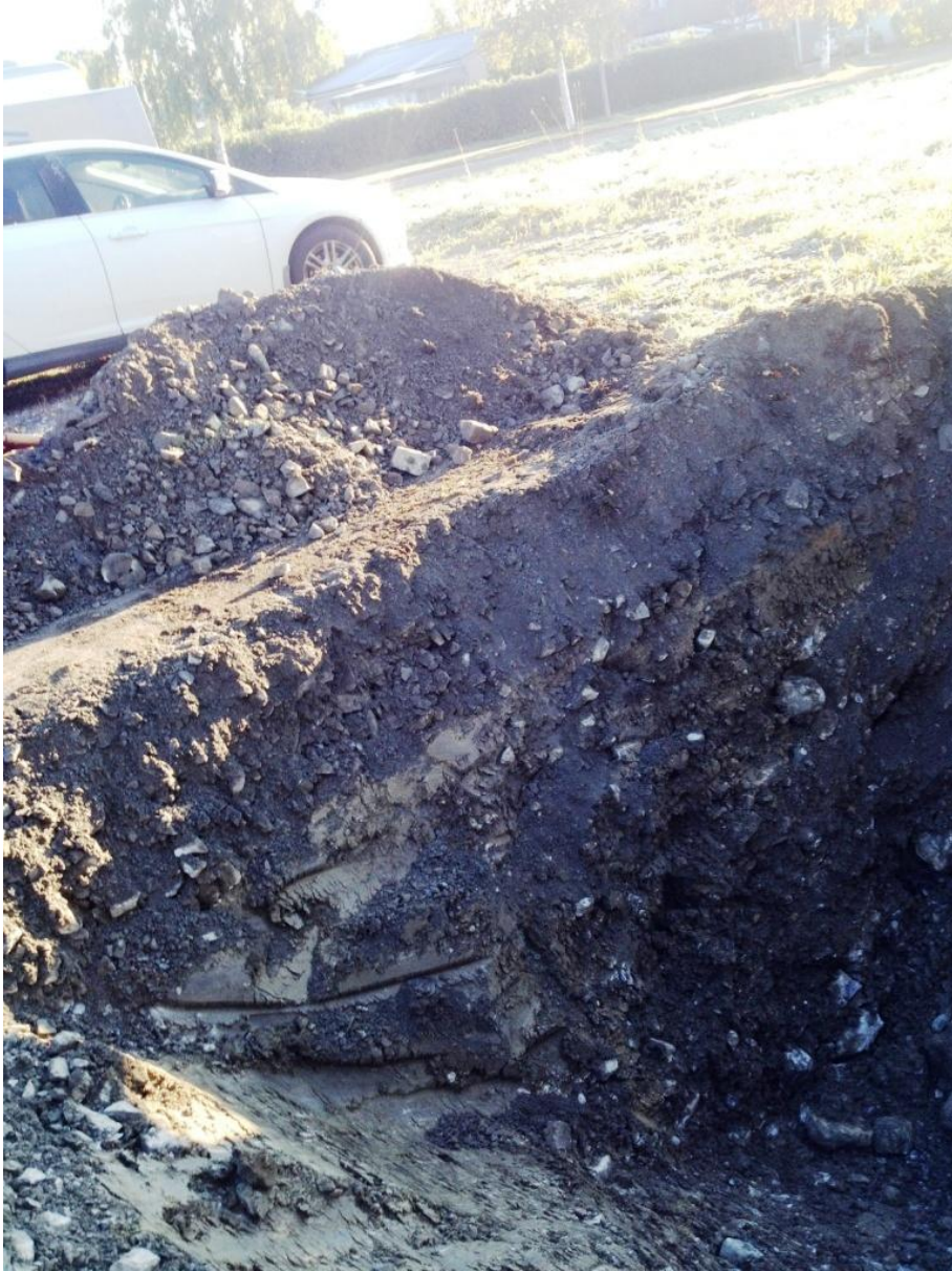
Foto 1. Provgrop i undersökningspunkt 14G01
