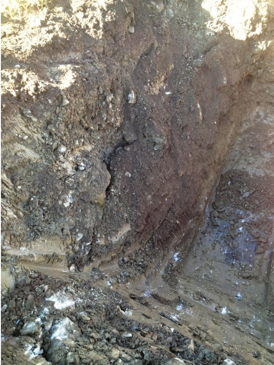
Foto 6. Provgrop i undersökningspunkt 14G06
