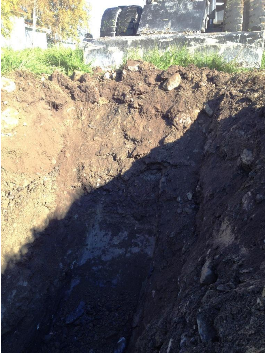
Foto 5. Provgrop i undersökningspunkt 14G05
