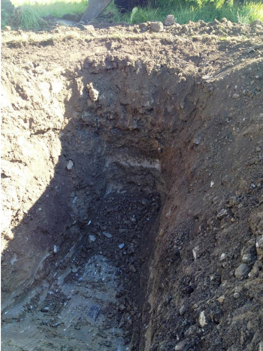
Foto 7. Provgrop i undersökningspunkt 14G07
