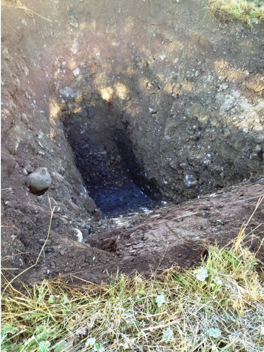
Foto 4. Provgrop i undersökningspunkt 14G04
