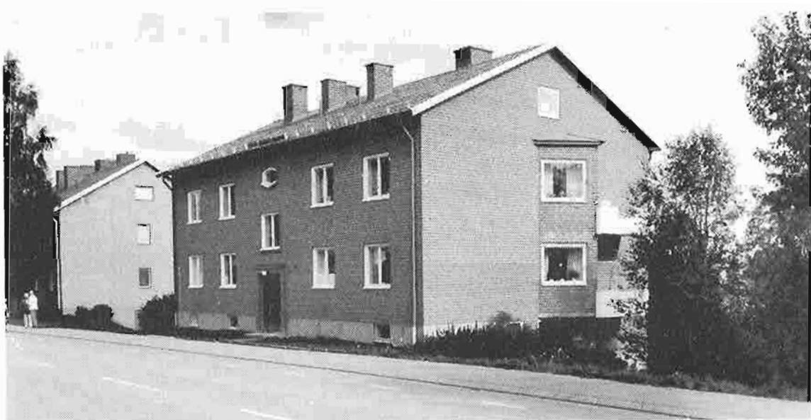
1950-tal. Flerbostadshus på Fritzhemsgatan. Rött tegel, enkel omsorgsfull utformning, tunn takfot.
