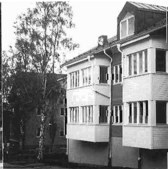
1990-tal. Kompletteringsbebyggelse för äldreboende vid Rådmanngatan. Putsfasad.
