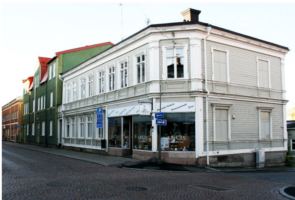
Gatubyggnaden på Skjutbanan 2, från 1885
