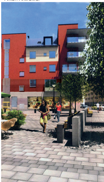
Torsgatan Stockholm - ny bebyggelse med torg och butik vid Lilla Bantorget Stockholm, här visad i nedsänkt variant - Arken Arkitekter 2010
