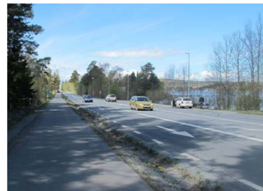
Väg 592 är idag utformad som en landsväg med separerad gång- och cykelväg och följer Storsjöns strand.
