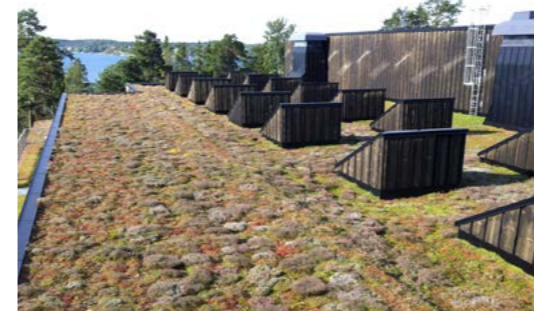
Gröna tak är ett effektivt sätt att fördröja dagvatten. Tjockare tak har större magasineringkapacitet.
