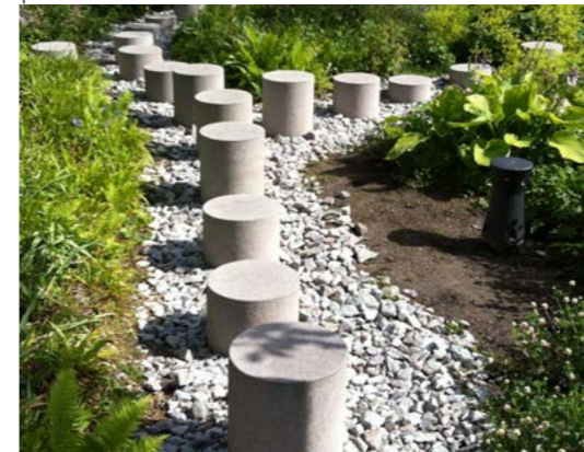
Dagvatten behöver fördröjas på olika sätt. Exempel på regnrädgård, en nedsänkt plats med planteringar som tillfälligt översvämmas vid stora regn.
