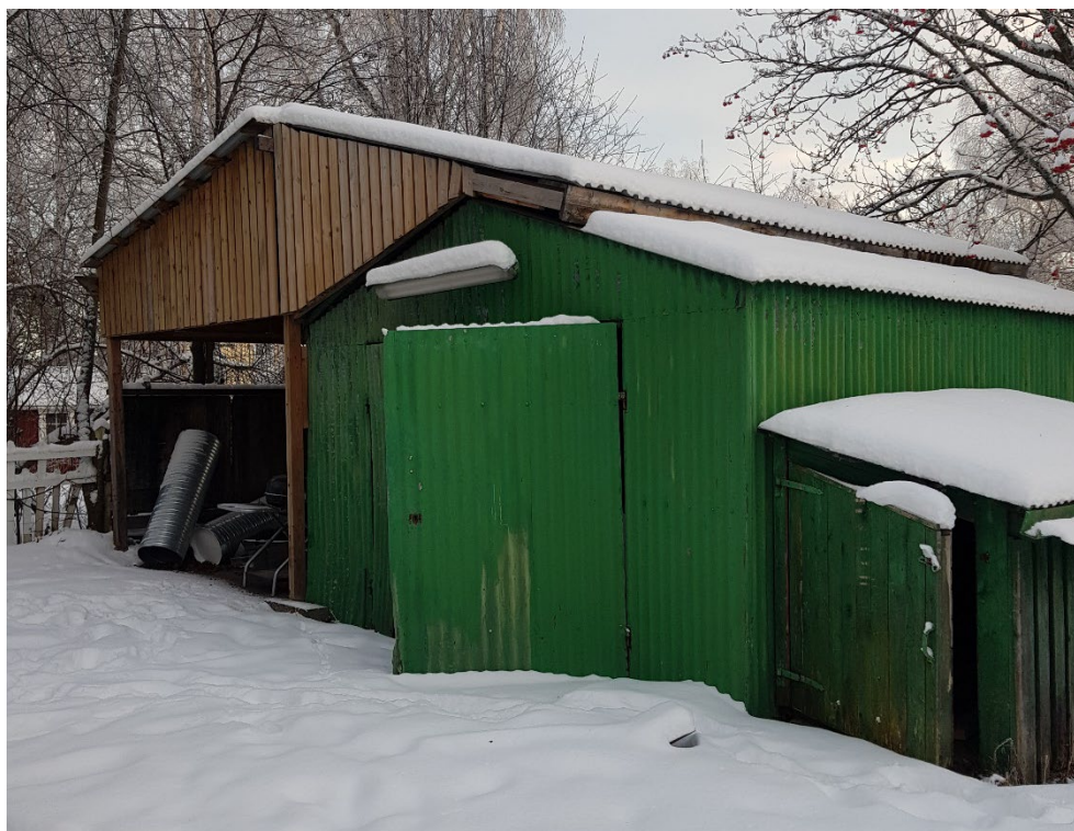
Garage/förråd inom planområdets sydöstra del.
