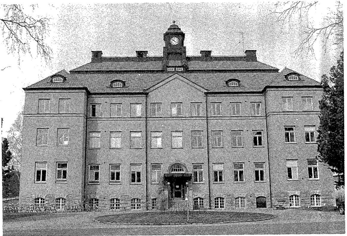
Klockhuset, gamla administrationsbyggnaden uppförd 1914
