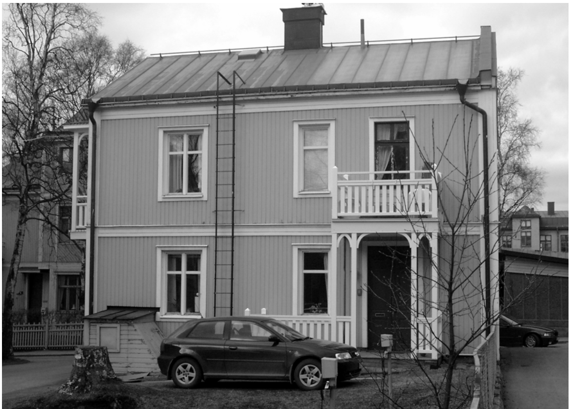
Mindre bostadshus vid Hamngatan uppfört kring sekelskiftet 1900.
