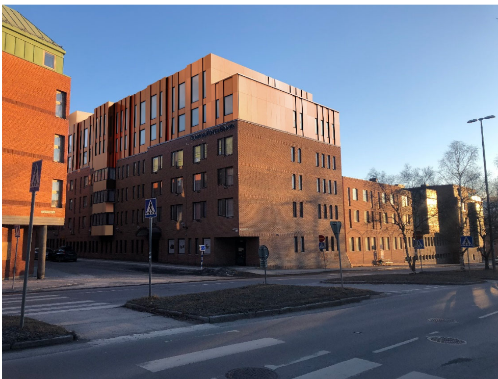
Påbyggnaden sedd från Färjemansgatan
