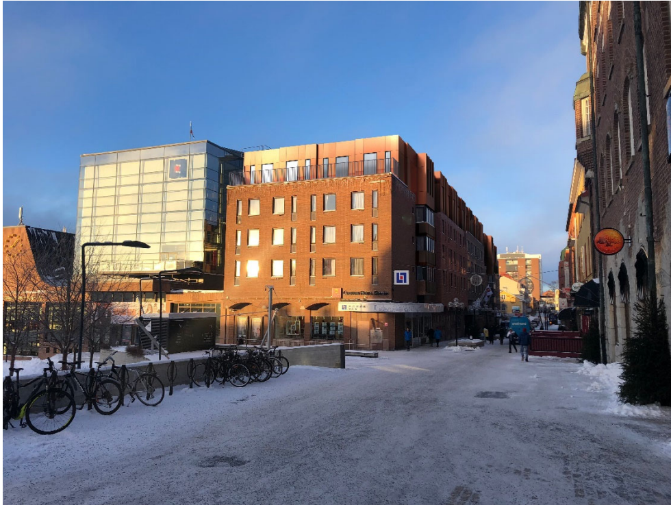
Påbyggnaden sedd från Prästgatan / Stortorget
