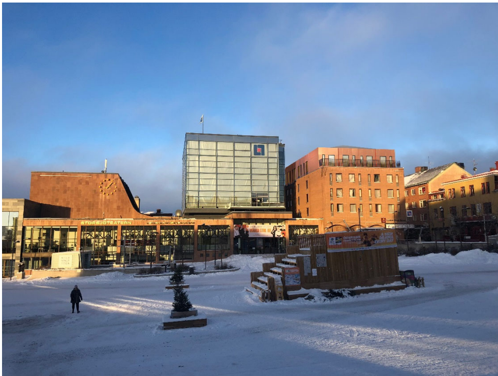
Påbyggnaden sedd från Stortorget
