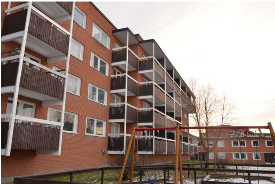
Bild 5. Vid en utökning av djupet på balkongerna är det viktigt att få till en god arkitektonisk lösning vid skarvarna mellan de olika balkongerna.
