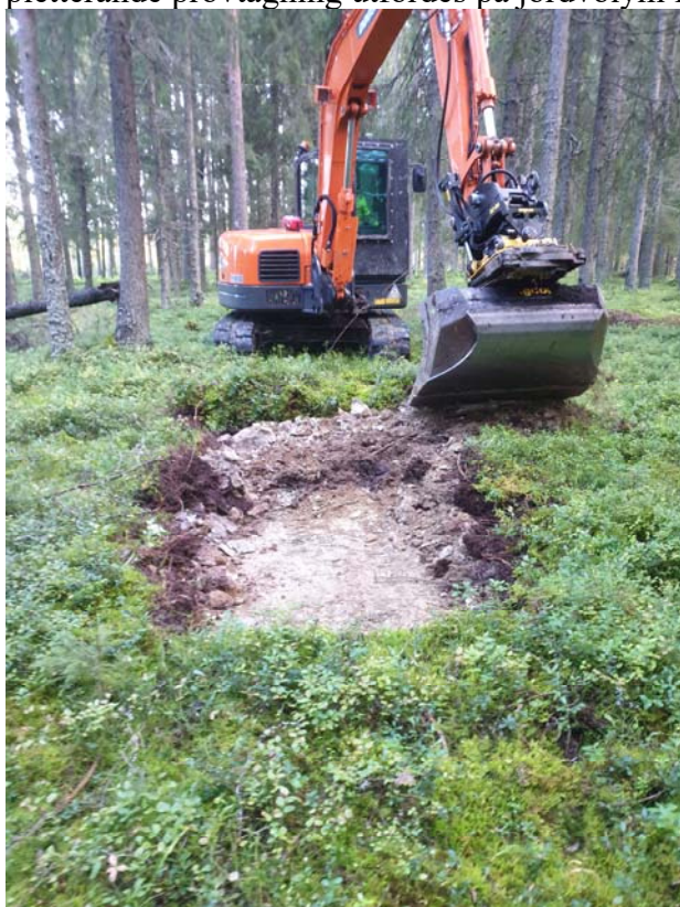
Figur 3: Provgropsgrävning pågår vid provpunkt 15.
