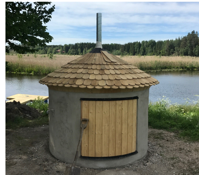
Pumphus som föreslås till infiltrationsdammar för bevattning av trädgårdsmästeriets odlingar. Gjord av brunnrings som isolerats och putsats och förses med ett tak av ekspån.
