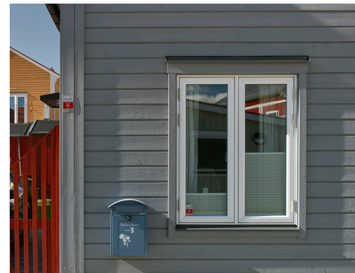
Tvålufts-fönster med fast mittpost i Hammaräng, Mariefred.
