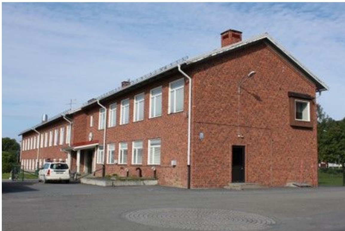
Figur 16: Foto som visar Häggenås skola och de kännetecken för en centralskola från 1950-talet. De kännetecknas av tegelfasaden, den smala volymen på byggnaden i 2-3 våningar.
