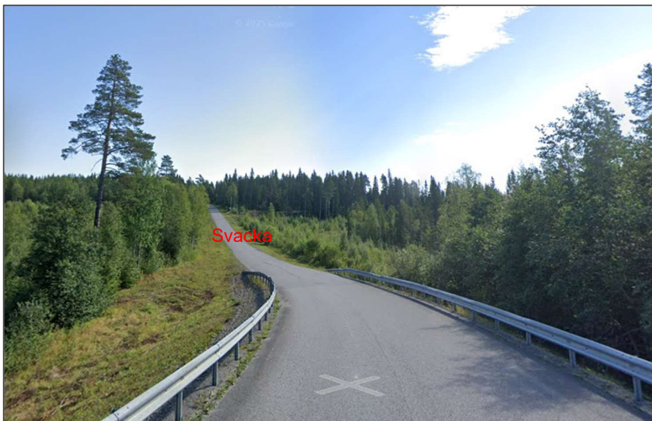
Figur 5-4. Skärmsklipp från Google Streetview på befintlig svacka.
