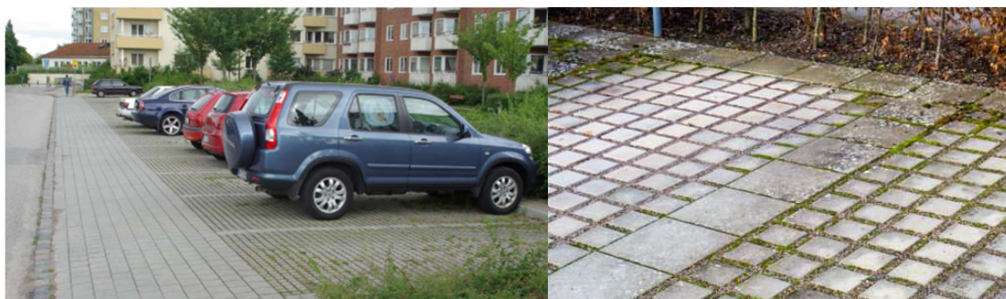
Figur 9 Exempel på genomsläpplig beläggning (Foto: Platsforvatten.vasyd/ Stockholmrvattenochavfall)
