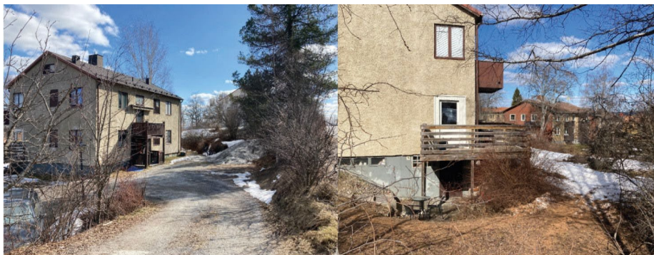
Befintlig byggnad mot Byvägen ska rivas.
