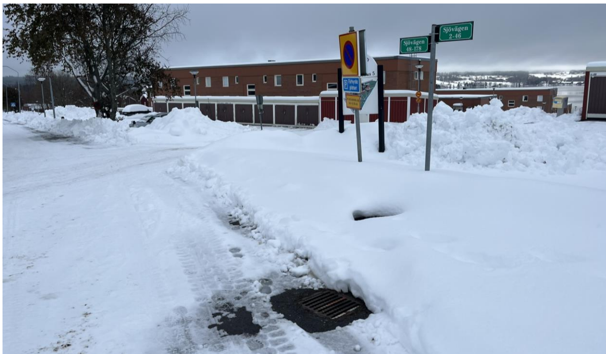
Figur 12. Dagvattenbrunn på Sjävägens västra sida, strax sydväst om planområdet. Mellan dagvattenbrunnen och skyltarna i fotot ses även en nedstigningsbrunn. Foton från platsbesök 2023-11-06.
