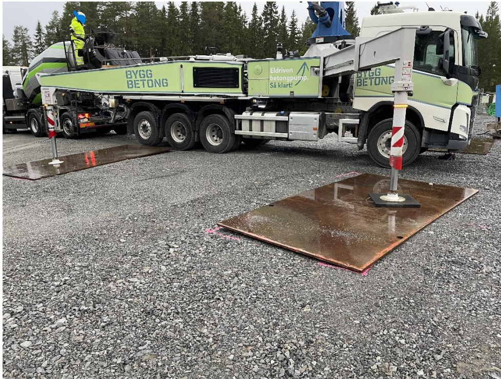
Figur 8: Ytterligare en bild på den elektriska betongpumpbilen från Bygg Betong. Foto: Skanska
