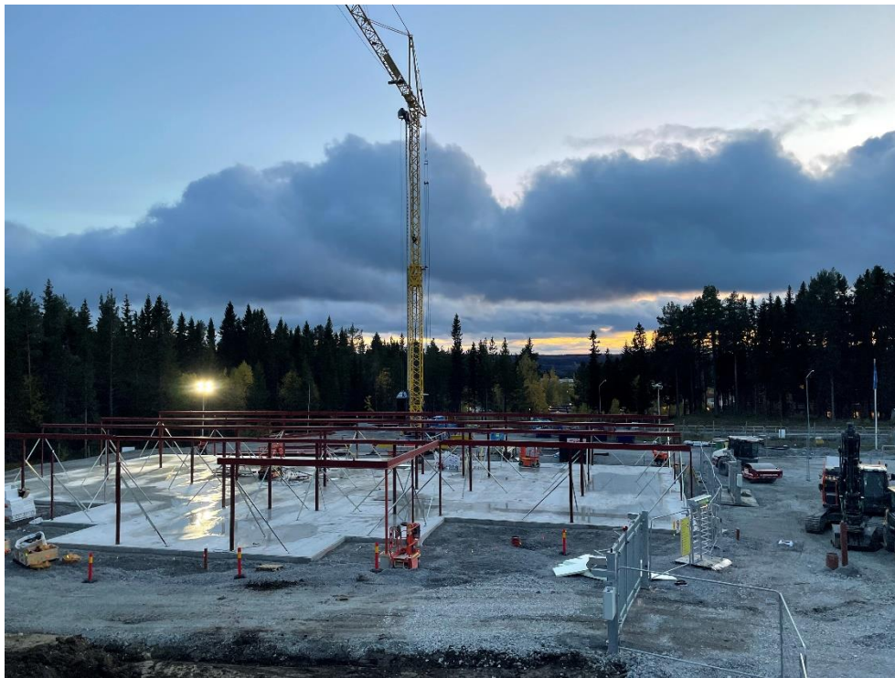
Figur 9: Elektrisk tornkran inne på området. Foto: Skanska
