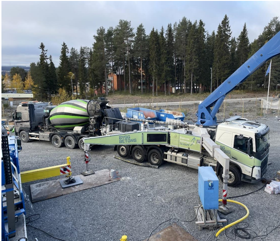
Figur 6: Den elektriska betongpumpbilen. Foto: Skanska
