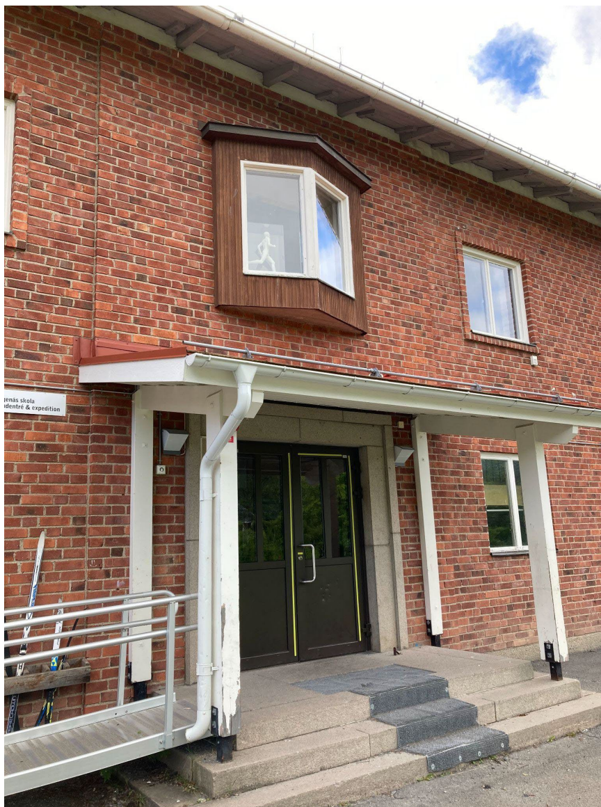
Figur 8: Foto som visar befintlig entré mot söder och föreslaget läge för hiss. Burspråket/fönstret ovanför entréns har inspirerat förslag på hissschaktets utformning och är ett exempel på hur den nya tillbyggnaden kan anpassas efter befintlig byggnad.
