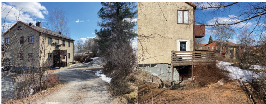
Befintlig byggnad mot Byvägen ska rivas.
