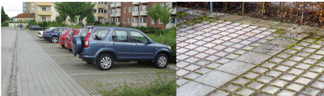
Figur 9 Exempel på genomsläpplig beläggning (Foto: Platsförvatten.vasyd/ Stockholmfvattenochavfall)
