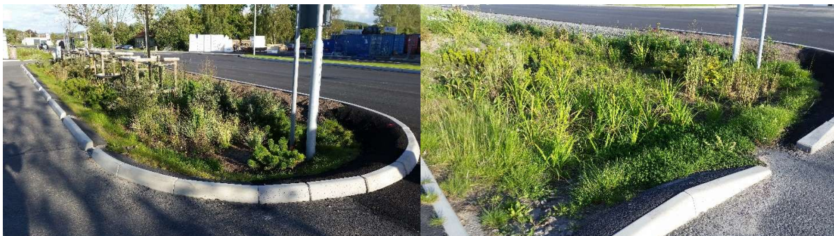
Figur 11 Exempel på nedsänkta växtbäddar (Foto: Norconsult)
