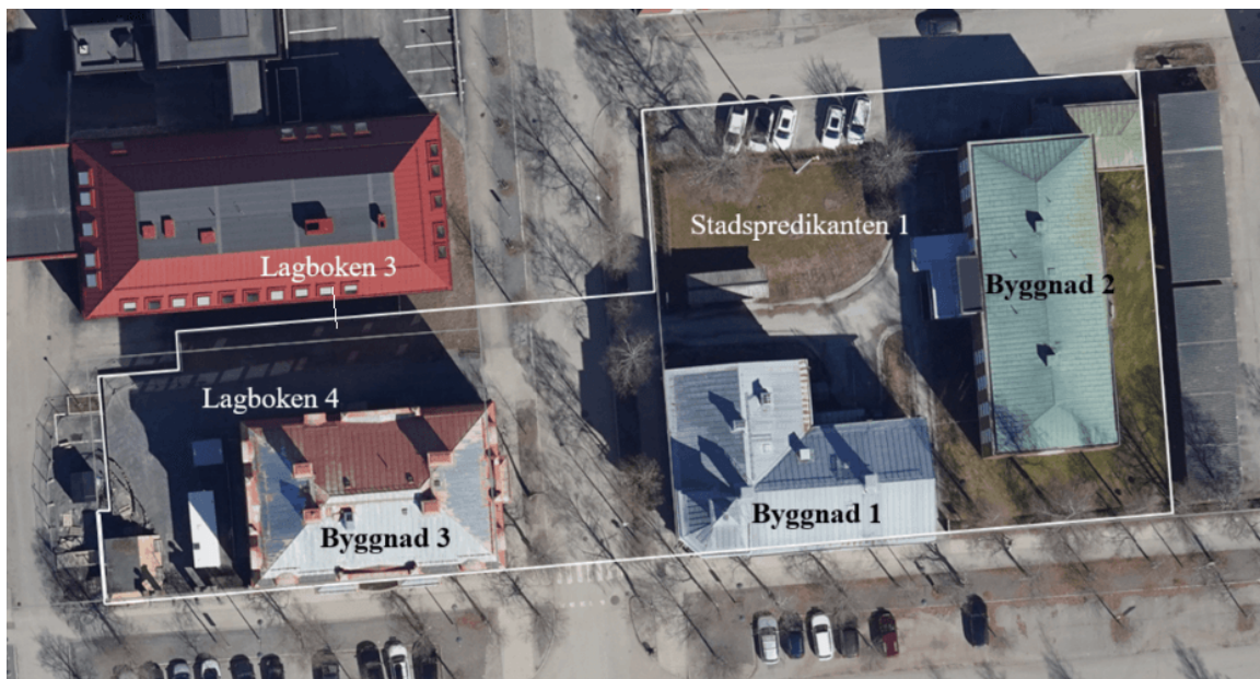
Figur 3: Befintliga byggnader inom planområdet.
