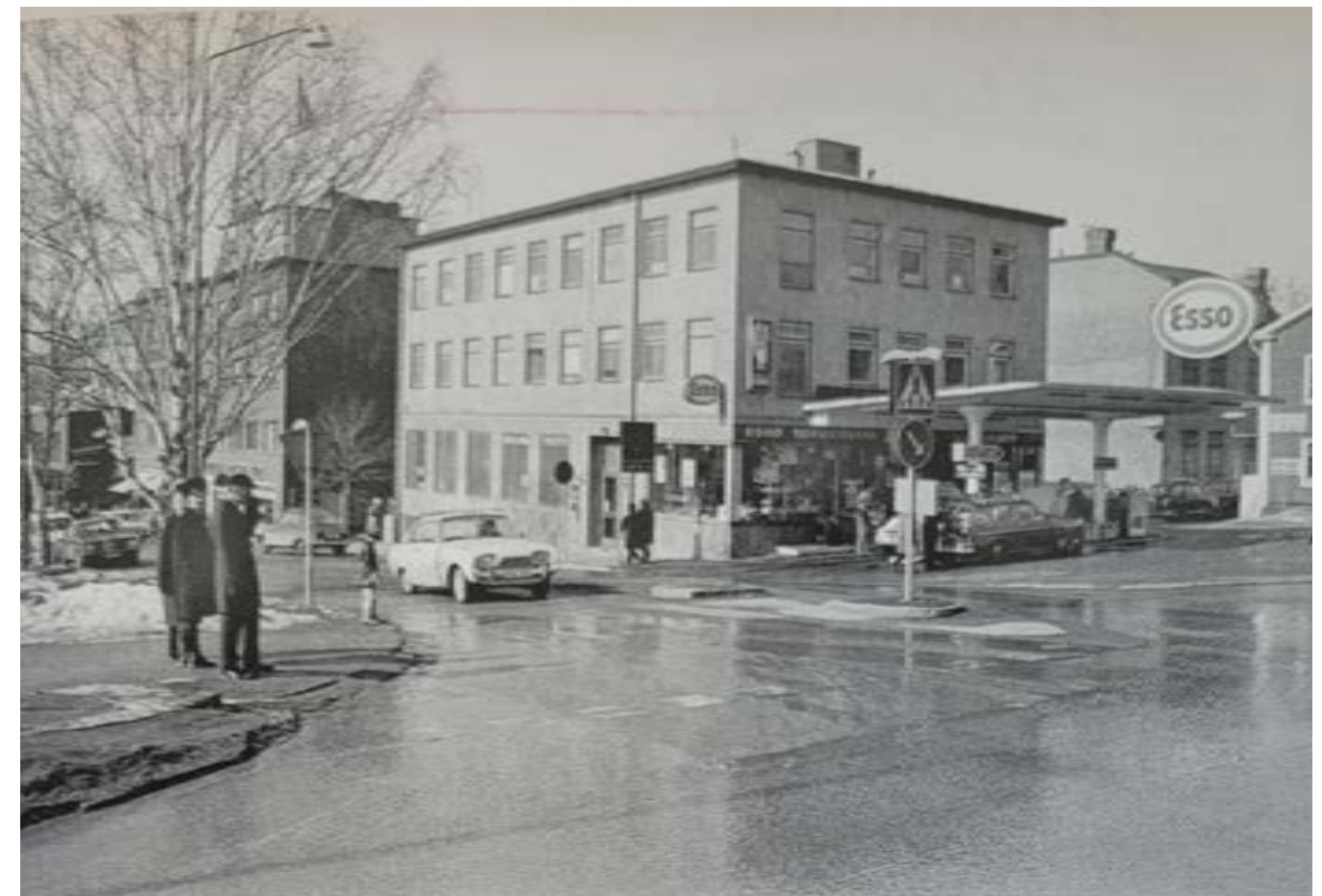
Essos byggnad med det eleganta skärmtaket ca 1970. Kombinationen servicestation och kontorshus är sannolikt ovanlig men talande för 1950-talets positiva syn på bilen. Foto: Föreningen Gamla Östersund
