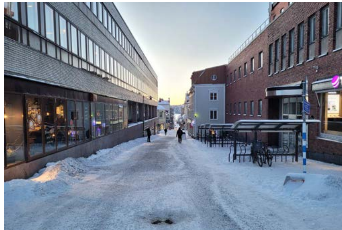
Vy västerut längs Hamngatan, som sluttar kraftigt ner mot Storsjön och Frösön. Denna lutning är påtaglig i stora delar av staden och präglade tidigare också Gustav den III:s torg i högre grad än nu, då höjdskillnaderna tas upp av stationsbyggnad och gradänger.
