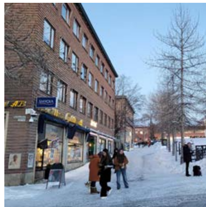
Del av fasaden mot Hamngatan. I släpljus framträder teglets materialitet och reliefverkan särskilt tydligt.
