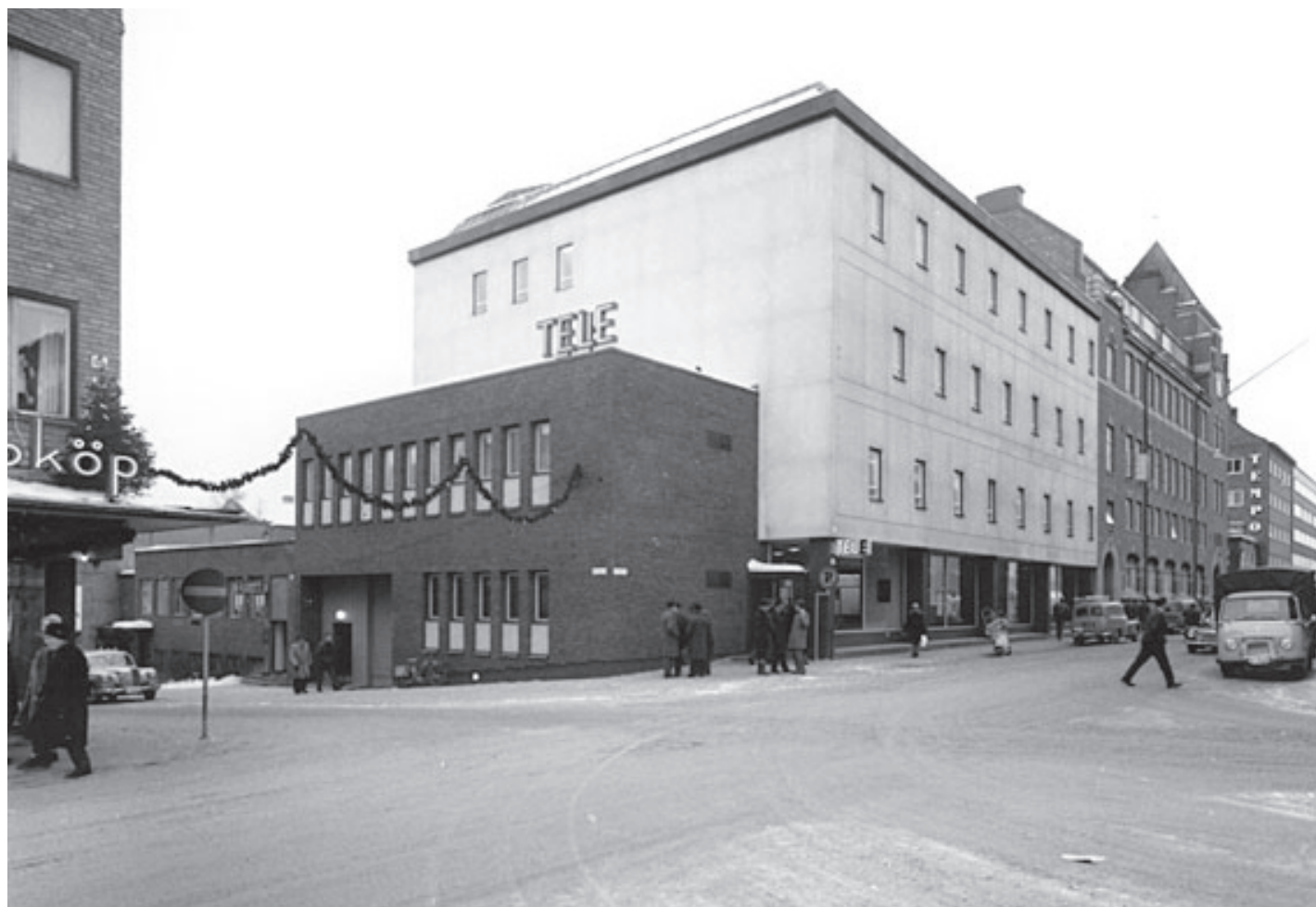
Tillbyggnad till Televerkets hus, foto från 1963. Foto: Hallings foto, Jamtli.
