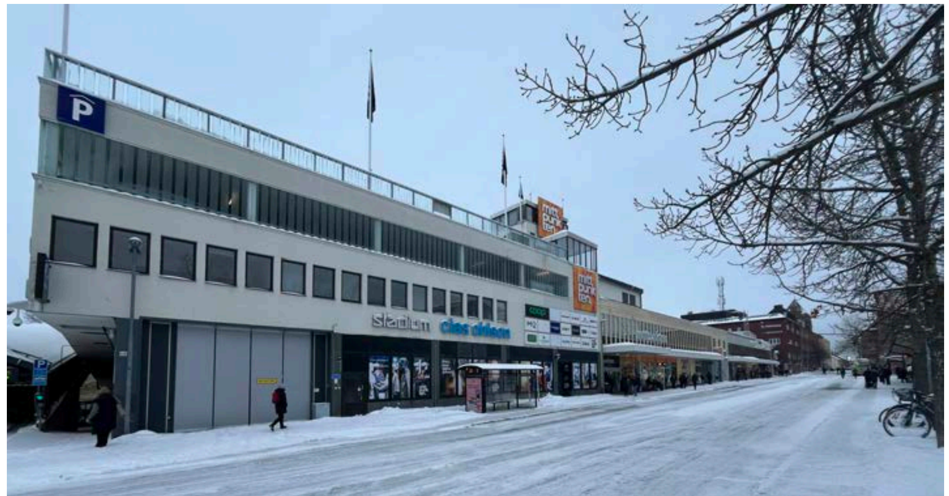
Varuhuset Mittpunkten, f.d. Domus, fasader mot Kyrkgatan. Södra byggnadsdelen från 1969 närmast i bild till vänster, och den ursprungliga delen från 1962 längre bort.
