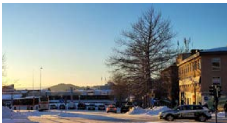
Byggnadens sydöstra hörn sett från Rådhusgatan. Franska balkonger på gaveln mot öst, längst till höger i bild
