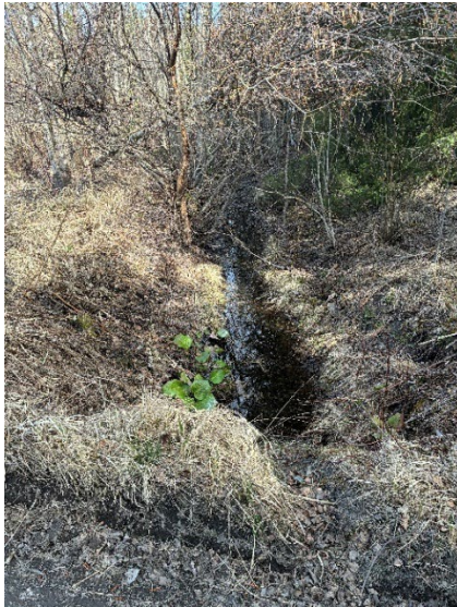
Diket väster om område för teknisk anläggning på norra sidan av vägen, vy från söder.
