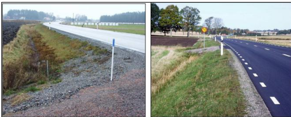
Figur 9. Exempel på gräsdike (Vägverket, 2003)
