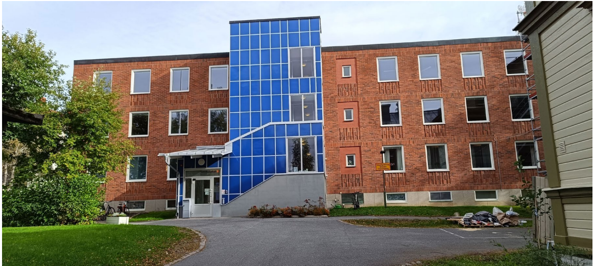
Figur 12: Kontorsbyggnaden på fastigheten Stadspredikanten 1.
