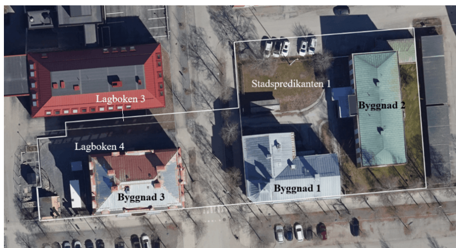
Figur 3: Befintliga byggnader inom planområdet.
