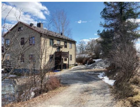
Befintlig byggnad mot Byvägen ska rivas.
