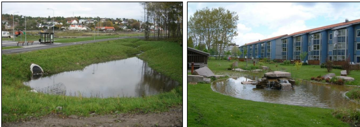
Figur 21. Exempel på dagvattendamm (Foto: Norconsult)
