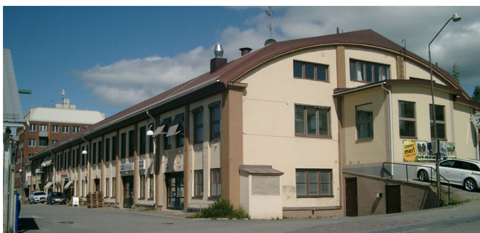
Gamla fabriksbyggnaden/verkstaden (idag bland annat bowlinghall).
