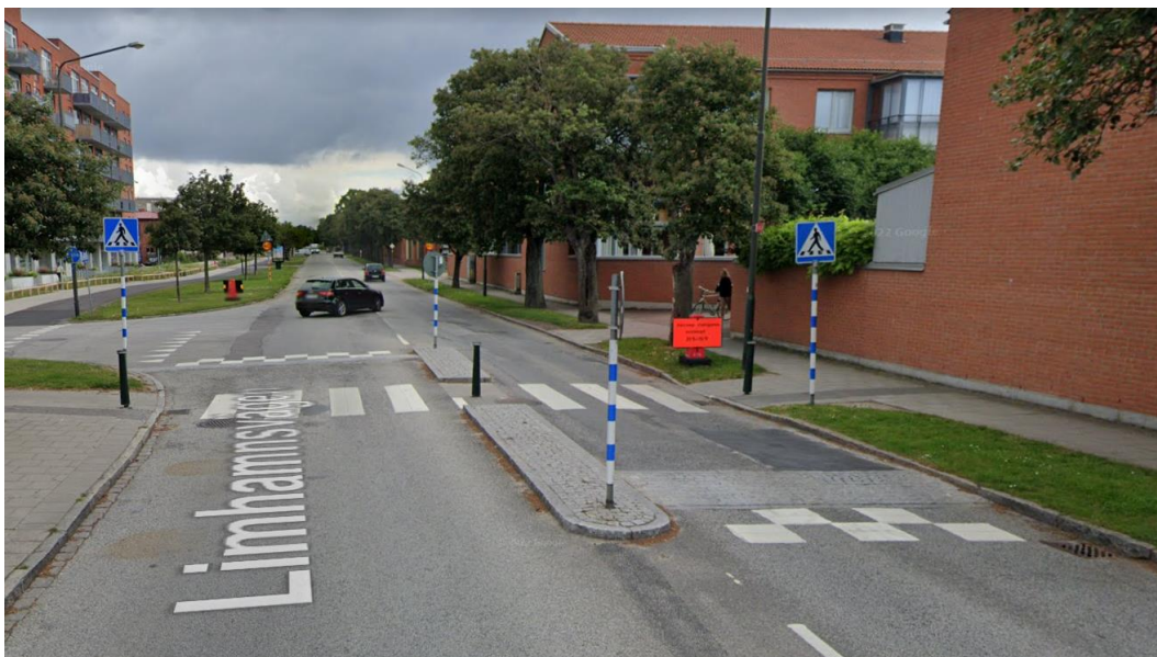
Figur 32. Exempel på så kallat Malmö-gupp med olika lutning in mot respektive ut från övergångstället.
