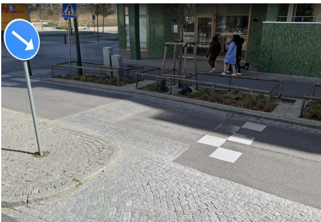
Figur 33. Exempel på så kallat H-gupp med olika lutning för större respektive mindre hjulavstånd.
