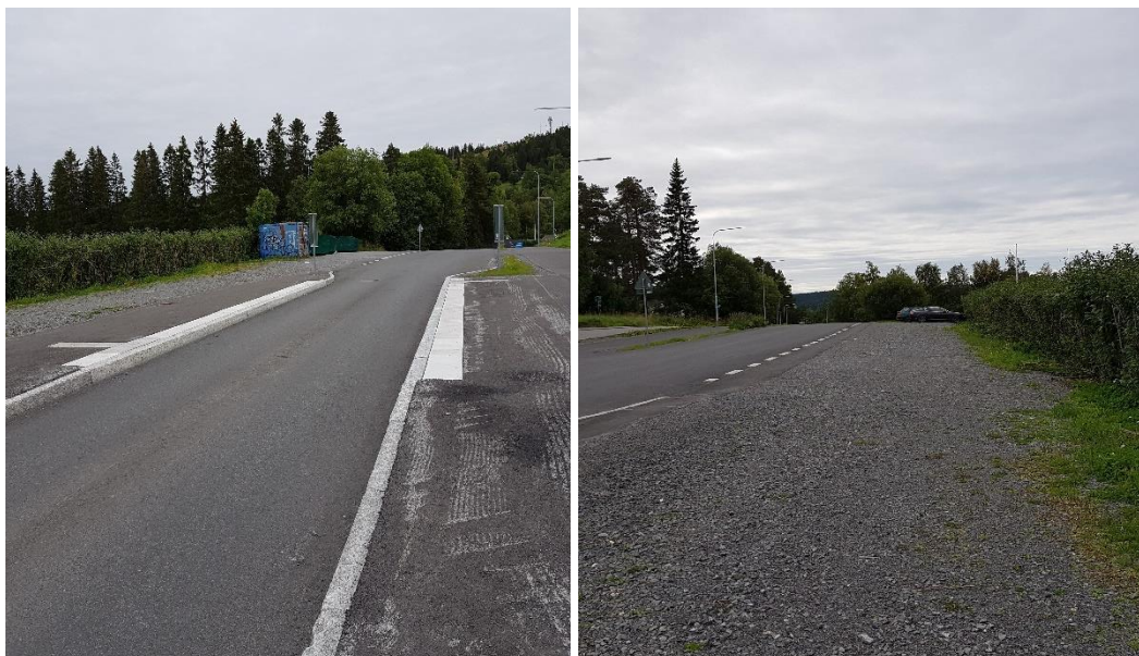
Figur 9. Avsmalning längs Mällbyvägen med återvinningsstation i bakgrunden (t.v), samt tvärställd parkering söder om avsmalningen (t.h.)
