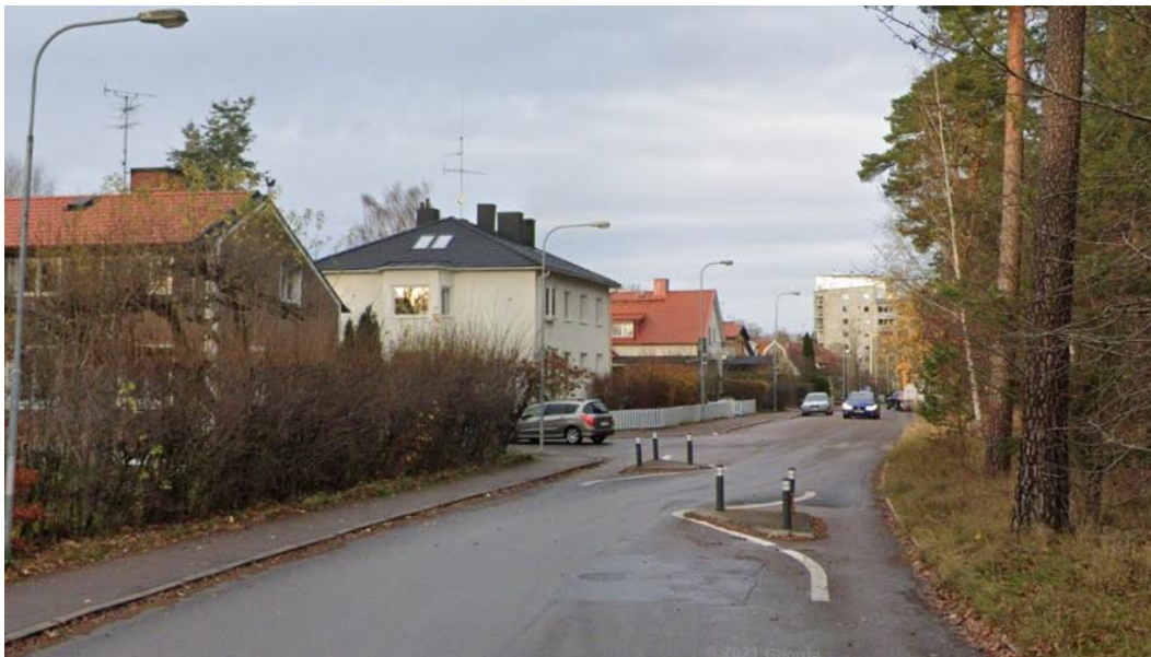
Figur 31. Exempel på farthinder lämpligt vid blandtrafik då motorfordonstrafikens tempo sänks utan begränsning av cyklisters framkomlighet.
