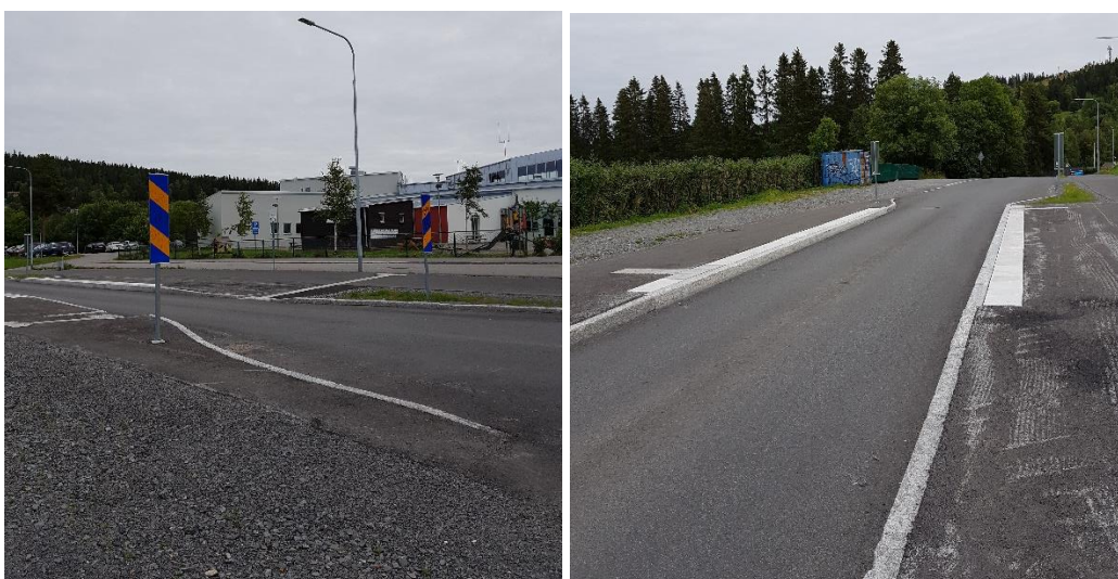
Figur 17. Nybyggd avsmalning för hållplats Ullberget vid Lövsta förskola.
