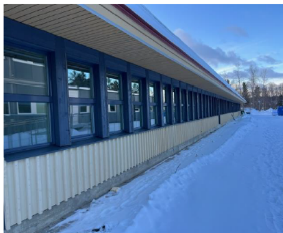
Norra fasaden B1
