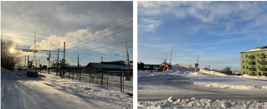
Figur 5. Vänstra fotot på den obehagliga passagen vid Verkstadsbacken och det högra fotot på bron över järnvägsspåret utmed Nedre Vattugatan.
