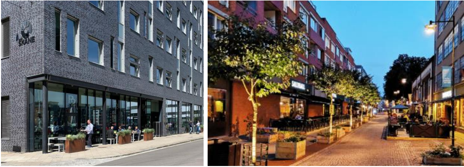
Figur 53 Fotot till vänster exempel på levande bottenvåning, Dockan Malmö (Levande bottenvåningar, Malmö stad, 2022). Fotot till höger visar exempel på gångfartsgata, Jönköping (Smarta gator, 2022)
