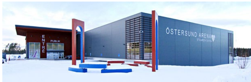
Östersund Arena, med entréparti i röd träpanel.
