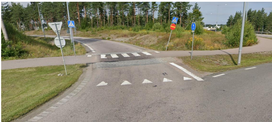
Figur 12. Upphöjd passage över avfartsramp för gående och cyklister, reglerad som övergångsställe. Bild hämtad från (Google Maps, 2024)
