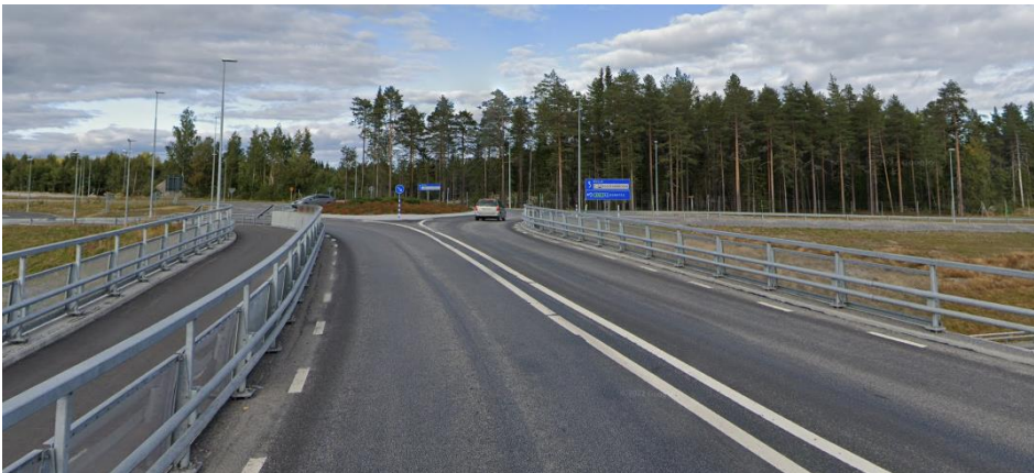
Figur 9. Sektion över bro där gång- och cykelbana avgränsas med räcke. Bild hämtad från (Google Maps, 2024)
