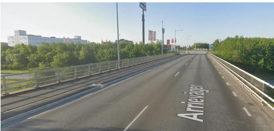
Figur 14. Sektion över bro där gång- och cykelbana avskilts med en refug av spikad kantsten. Bild hämtad från (Google Maps, 2024)
