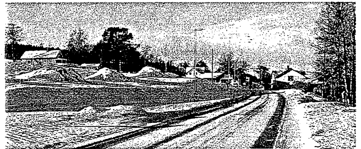
Bullerdämpande slänt längs väg 604
